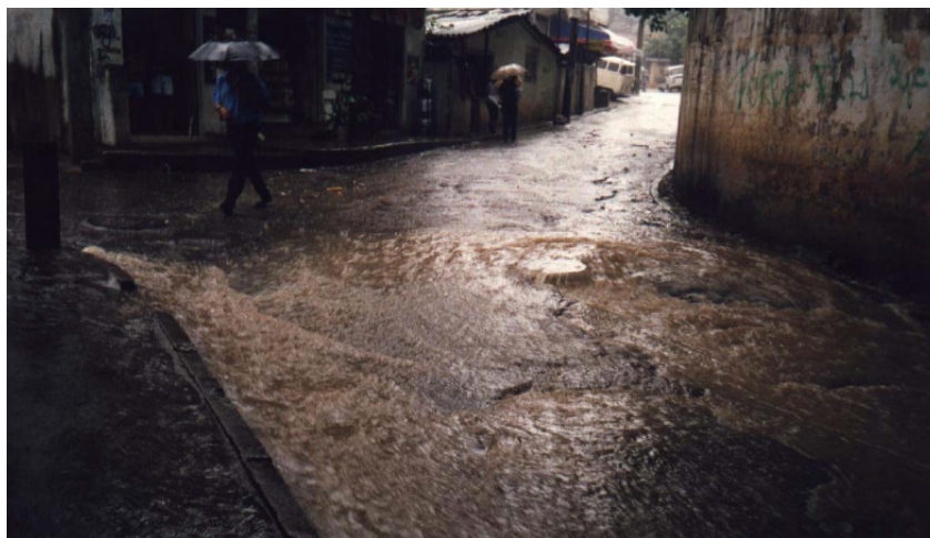
“Vista do tampão da rede de drenagem transbordando águas pluviais e esgoto (rua Stella Maris)” (SMH 2003, p. 87)
