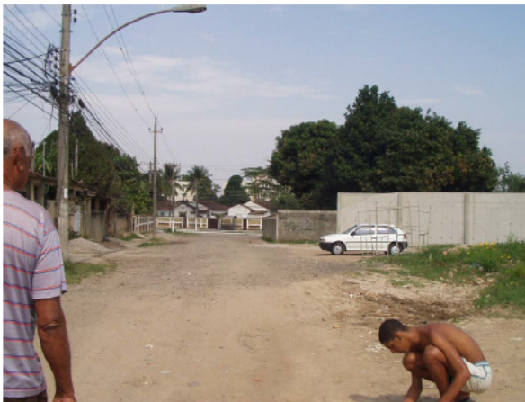
“Muro da Aeronáutica em construção, prestes a interromper a rua 74” (SMH 2003, p. 122 )
