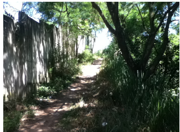
Muro da Aeronáutica concluído (Pesquisa CESeC, fevereiro de 2012)
